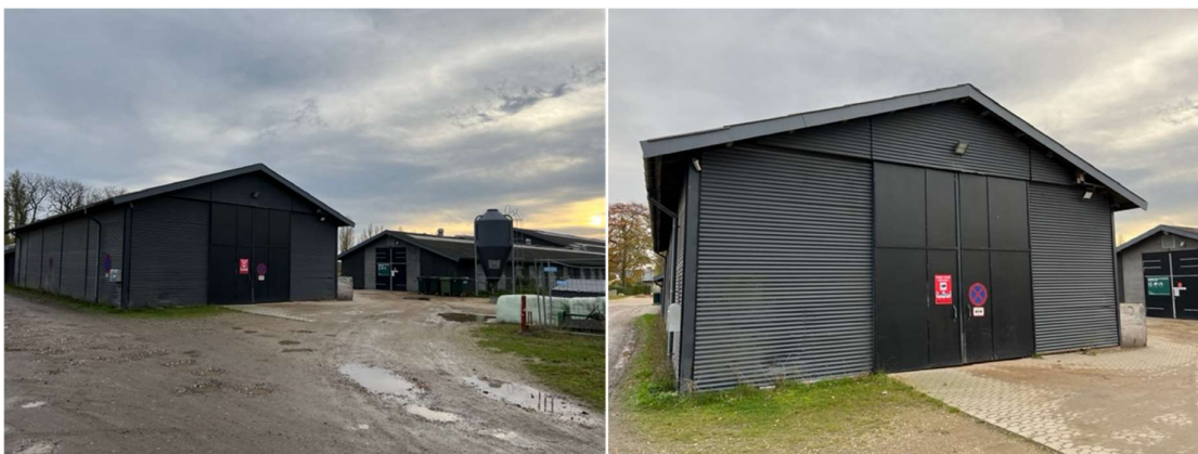
Foto 3. Ridecenterets nærliggende bygning.
