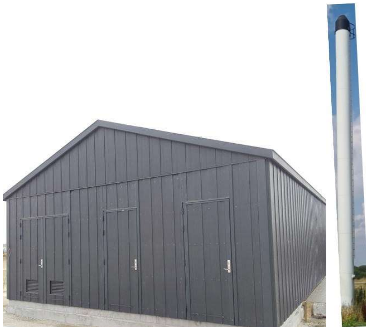
Foto 2. Bygning til varmepumpe med skorsten fra et tilsvarende projekt.
