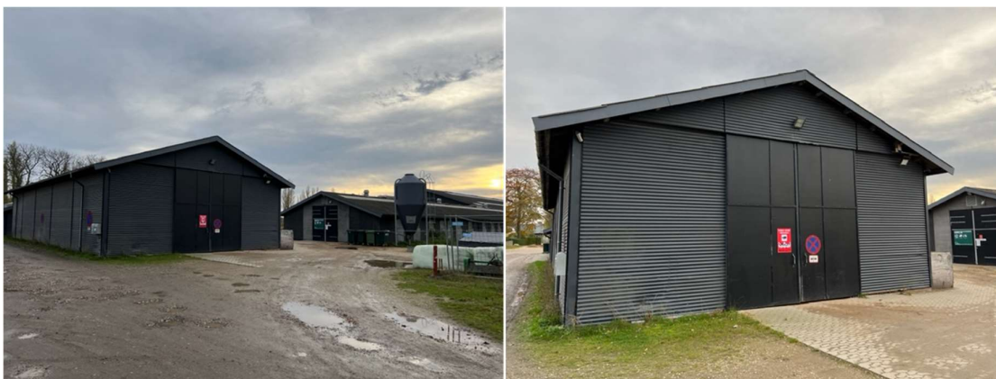
Foto 3. Ridecenterets nærliggende bygning.
